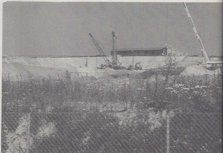
Teilansicht der Baustelle
