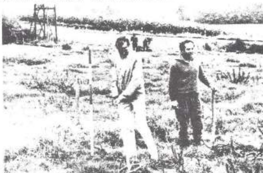
Seit gestern sind Angehörige des Kampfmittelräumdienstes dabei, das Baugelände des Bunkers nach Munition abzusuchen.
